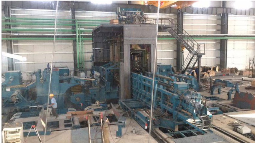
圖 2：車間四號(二期)安裝單機架六輓可逆軋機
