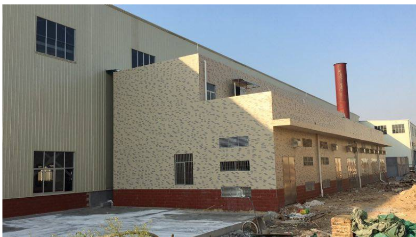
圖 1：睦洲鎮現有生產廠房車間四號(二期)
